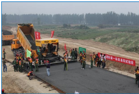
水泥稳定碎石层施工实例图
