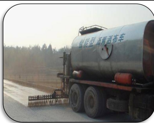
沥青透层、粘层施工实例图
