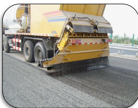
矿料铺撒施工实例图
