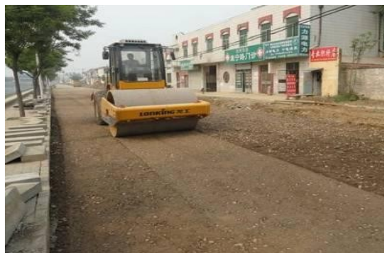
级配碎石铺筑碾压
