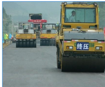
沥青路面施工实例图
