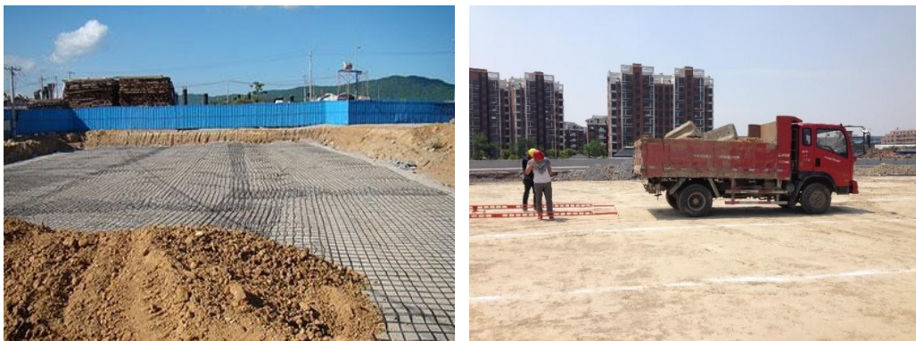
宕渣填筑实例图
