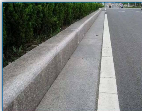
侧平石施工实例图
