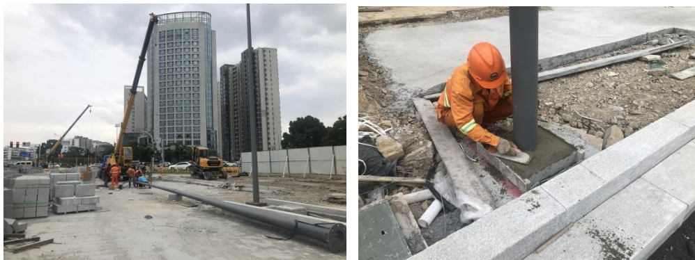
路灯安装施工实例图
