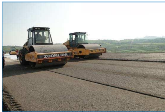
水泥稳定碎石层施工实例图
