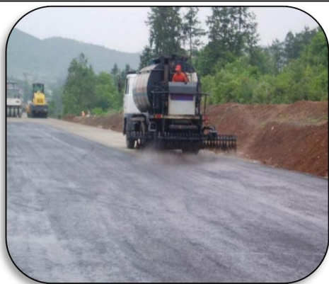
沥青透层、粘层施工实例图
